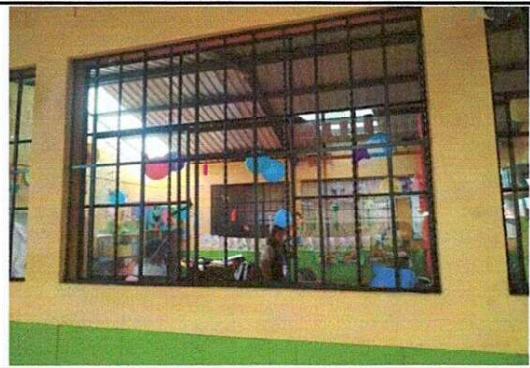
Foto 4: Mantenimiento de 14 ventanas y balcones de estructura metálica
