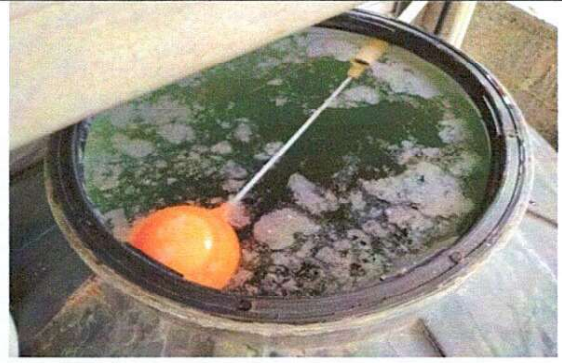
Foto 2: Mantenimiento de tinaco, limpieza y cambio de accesorios
