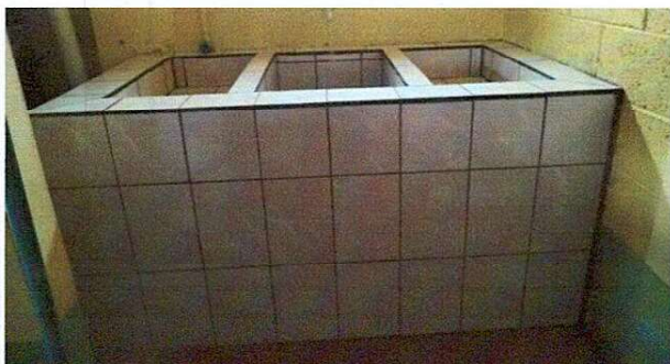
Foto 3; Sustitución de pila, 160x80x100, azulejado más mano de obra
