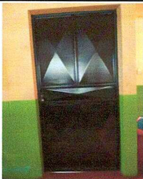
Foto 1; Mantenimiento de 9 puertas de metal, lijado, rectificación, aplicación de anicorrosivo+esmalte
