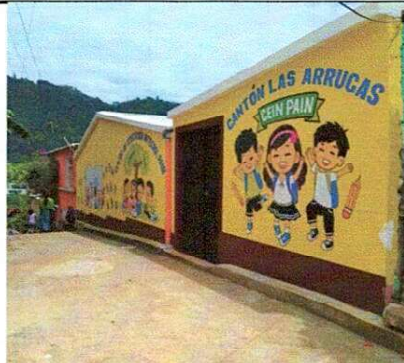
Foto 2; Pintura de fachada exterior e interior
