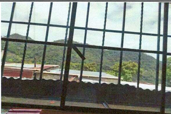
Foto 3: Sustitución de una ventana y balcon de metal
