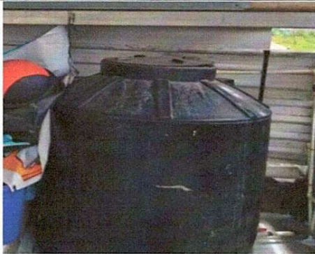
Foto 1: Mantenimiento de tinaco, limpieza y cambio de accesorios
