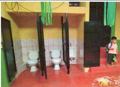
Foto 5: Rehabilitación de pared que resguarda las baterías, instalacion de 2 sanitarios y 1 mingitorio
